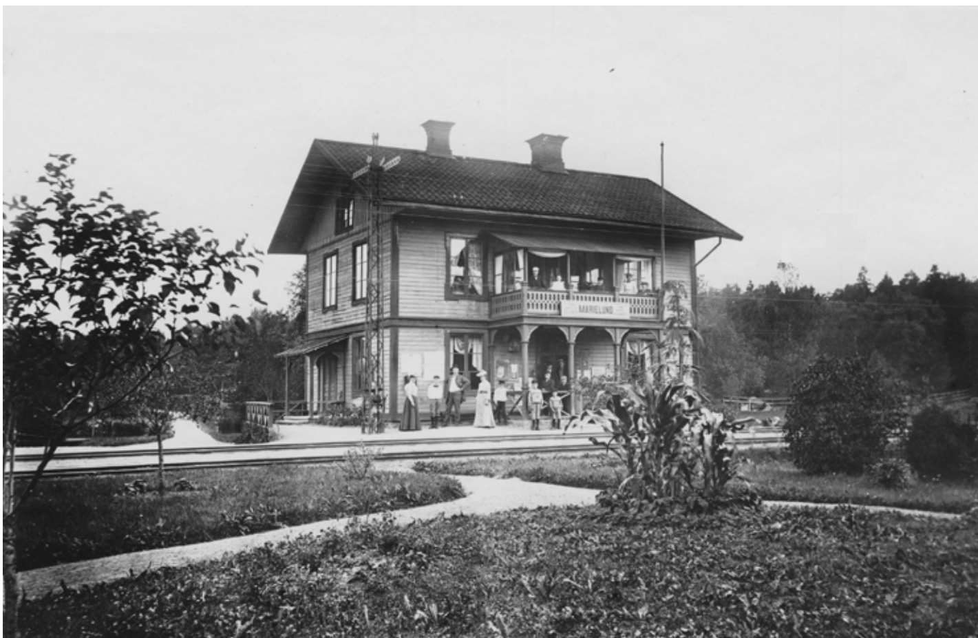
Marielunds station uppfördes 1877 i "Schweizerstil". Under första hälften av 1900-talet förenklades utsmyckningarna successivt till dagens utseende. Foto av Johan Lundin ur Upplandsmuseets samlingar.
